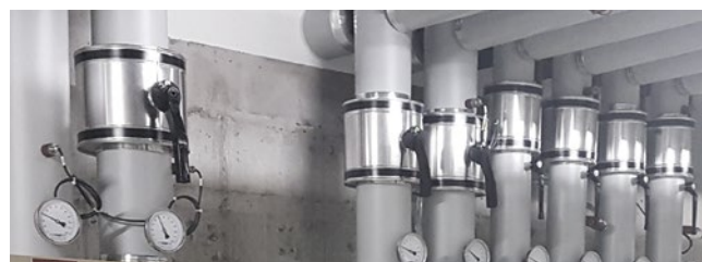
[FIG. 12] Nel limite del possibile, i tappi della rubinetteria facili da smontare devono essere adattati all'isolazione della condotta.
