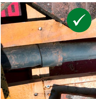
[FIG. 34] Qui è stato eseguito un risparmio nella controlistellatura e la condotta isolata in continuo.
