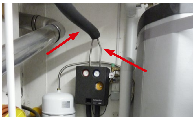
[FIG. 41] Prolungare l'isolazione fino alla stazione solare.
