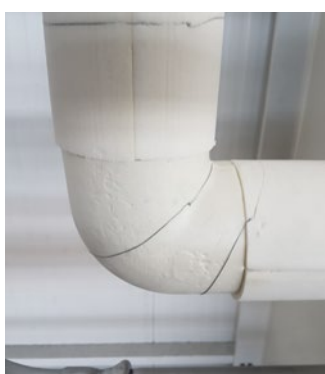
[FIG. 9] Isolazione di una curva per mezzo di un modello prefabbricato in espanso.
