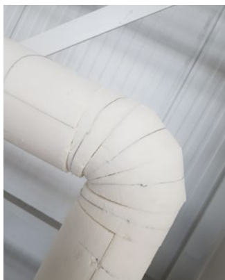
[FIG. 10] Isolazione di una curva per mezzo di segmenti di mezzette in PIR.
